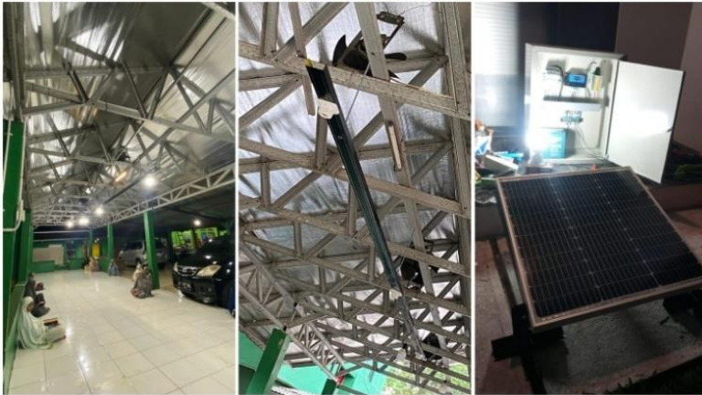
Gambar 4. Pengujian Sistem Penerangan Sumber: Dokumentasi di Lokasi PKM
