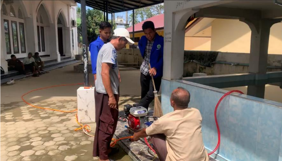
Gambar 3. Pemasangan alat dan proses pembersihan awal.
